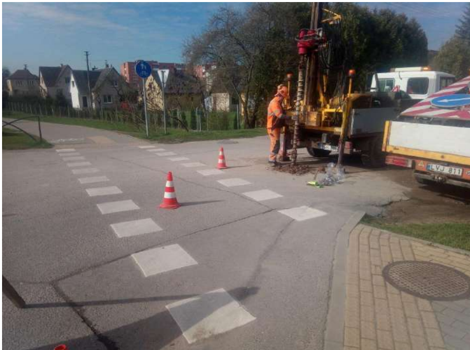
1 pav. Lauko darbai
